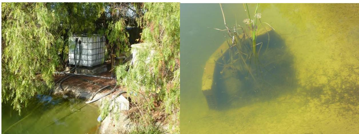
Concepto nuevo (izq.): bidón y tubos de tamaño proporcional a la cantidad de agua. Dos salidas después de la filtración bio-mecánica, una normal y otra de emergencia por si se satura. Una llave de paso para que el agua entre vía las cámaras de abajo, así se evitará el vaciado con un corte de luz. Las instalaciones eléctricas deben ser hechas por un profesional.
